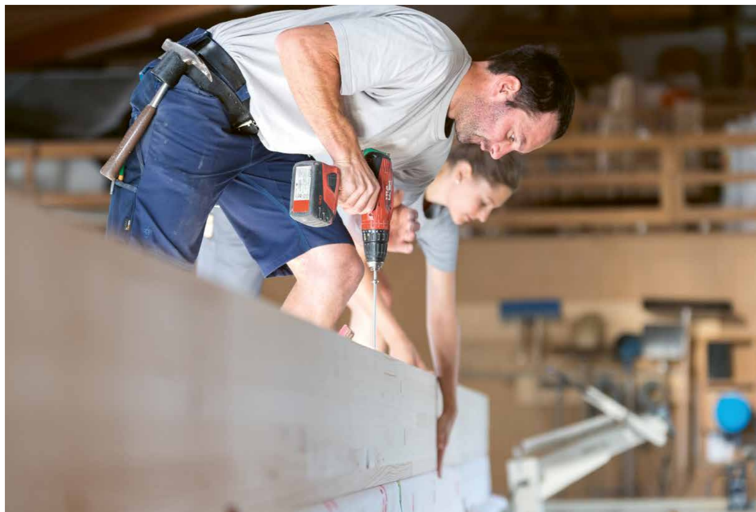
Produktion eines Dachelementes in der Werkhalle
